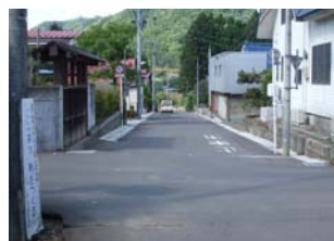
南赤石地区での市道改修が一部完了
