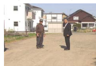
鉤取新田地区での下水道管布設の調査
