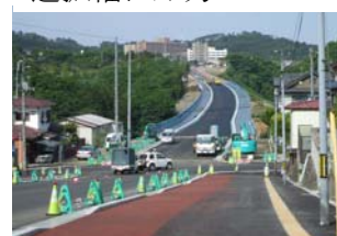
完成真近かの都市計画道路川内旗立線
